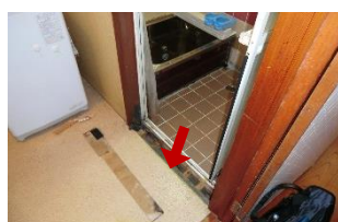
浴室出入口ドアまわり (入口の床をはがすとシロアリによって下地がボロボロに...)
