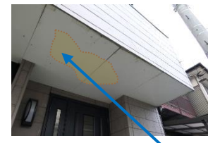
ベランダの底側の変色は雨水のしみ込み
